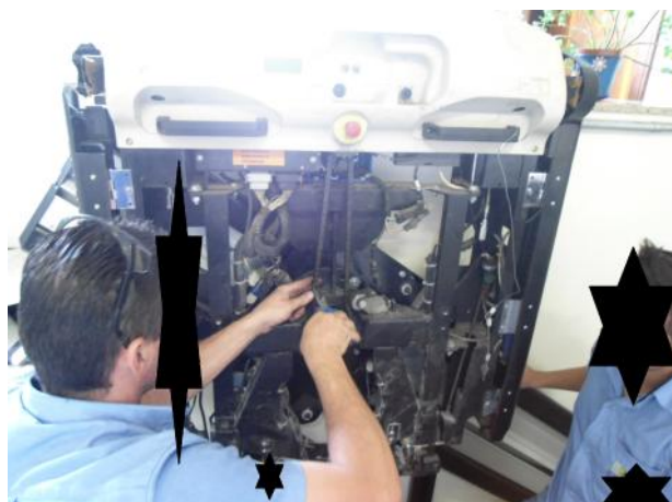
Figura 14-Manutenção de uma plataforma para deficientes. Fonte: Arquivo próprio
